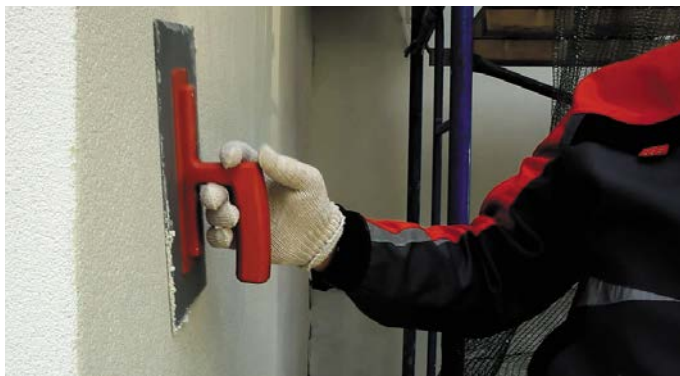
Рис. 18. Нанесение декоративного слоя штукатурки
