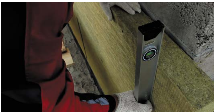
Рис. 8. Приклейка плиты тепло-, звукоизоляции к стене
