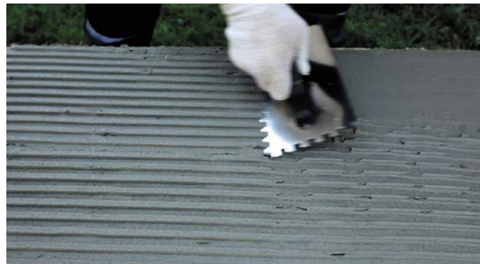
Рис. 4. Нанесение клеевого состава на плиту сплошным методом приклейки
