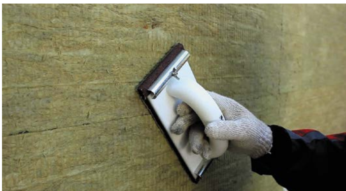
Рис. 12. Шлифовка стыков плит теплоизоляции наждачной бумагой
