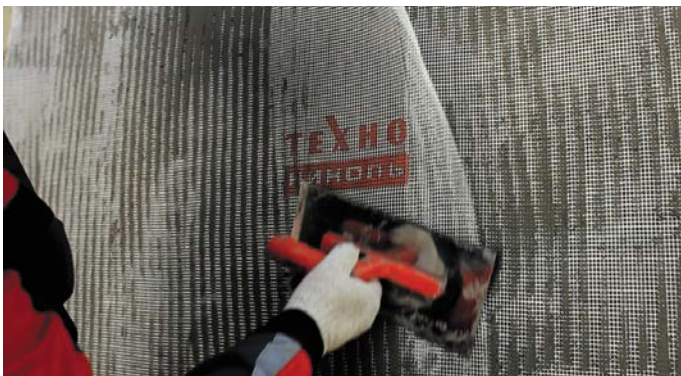
Рис. 16. Монтаж базового штукатурного слоя, армированного стеклосеткой
