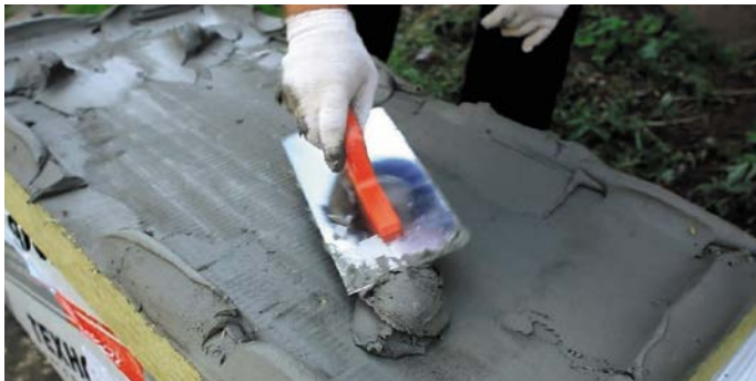
Рис. 6. Нанесение клея на плиту контурно-маячковым методом приклейки
