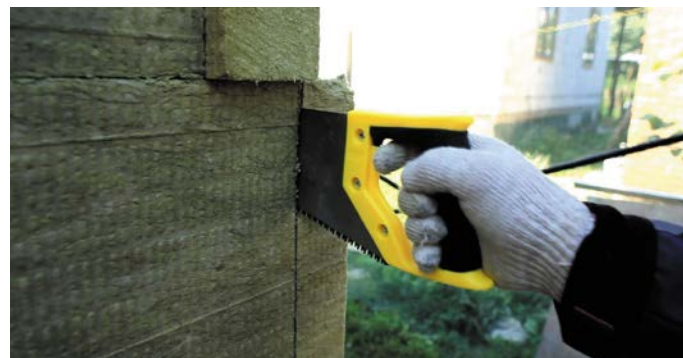
Рис. 10. Зубчатая перевязка плит на наружных углах здания
