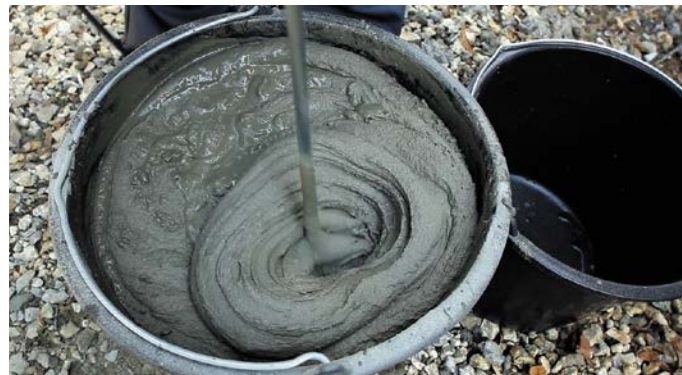
Рис. 3. Замешивание клея для приклейки теплоизоляции
