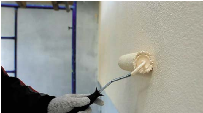
Рис. 19. Нанесение краски на поверхность фасада
