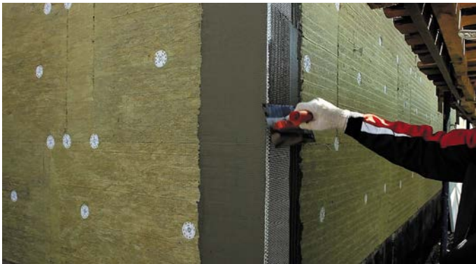
Рис. 15. Установка усиливающих профилей на углах здания
